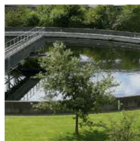
Tratamiento de agua
